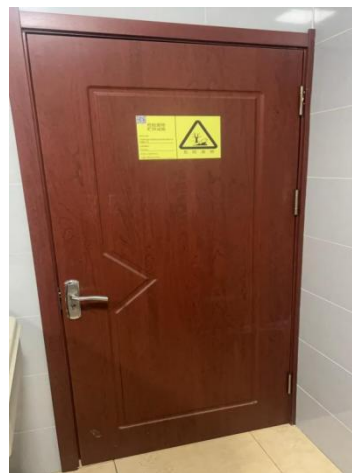
图 3-4 危废暂存间内部、外部
